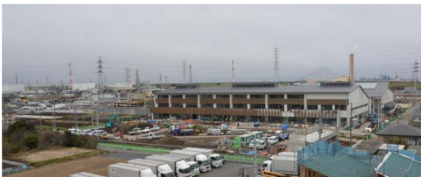
2 月 15 日現在の下新倉小学校建設現場（和光市ホームページより）
